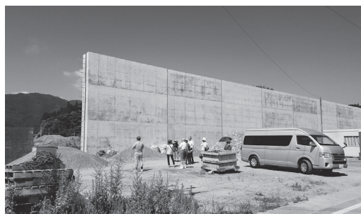
防潮堤の見学
